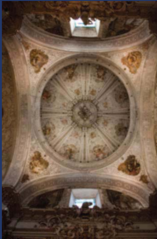
Fig. 2. Juan de Valdés Leal. Bóveda. Iglesia del Hospital de la Santa Caridad. Sevilla.
