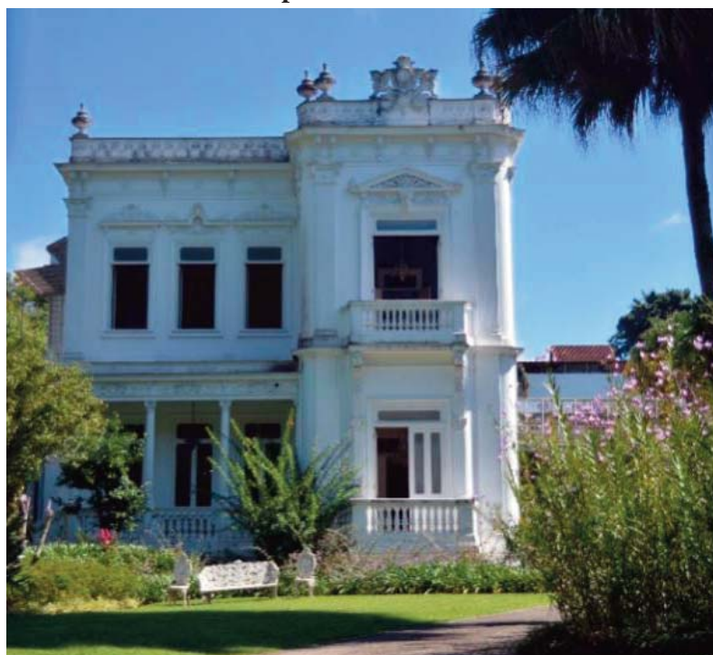
Casarão Barão de Teresópolis - Avenida Koeller, nº144 – Centro.
